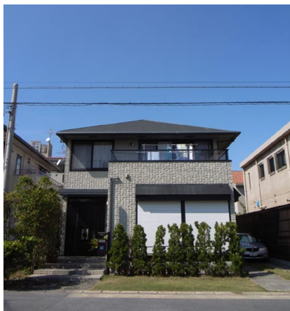
写真 35 ハウスメーカーのプレハブ住宅（那覇新都心）
