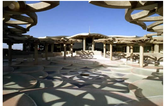
写真 41 沖縄コンベンションセンター
