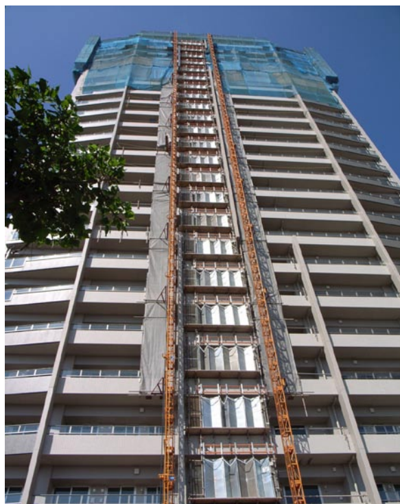
写真 34 建設中の高層マンション（那覇新都心）
